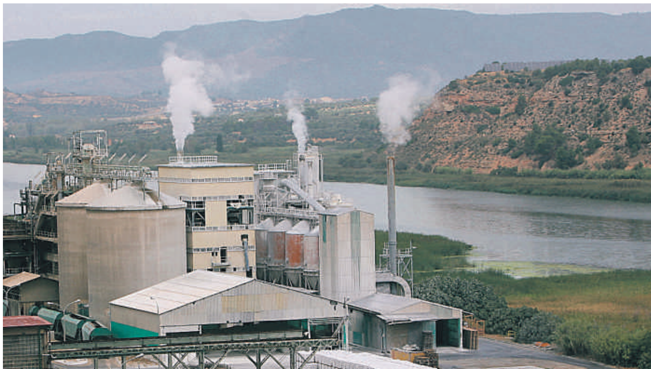
Entre 1988 y 1993 la factoría de Erkimia, ubicada junto al río Ebro, generó unas 700.000 toneladas de lodos tóxicos
